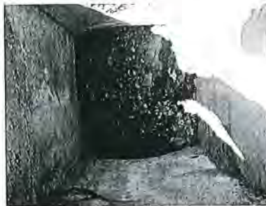
Foto 1 Alcantarillado Plataforma Baja
