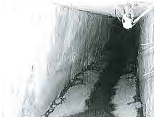
Foto 2 Salida del Alcantarillado Pluvial.
