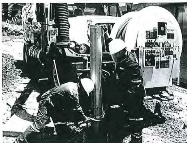
Foto 5 Limpieza de los Pozos
