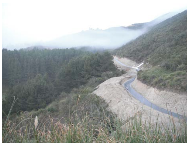
Fotografía 2. Vista general del canal recolector de agua lluvia.
