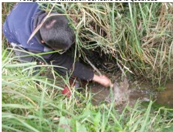
Fotografía 2. Remoción del lecho de la quebrada
